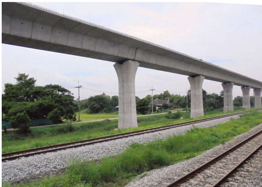
Fig. 4. Le chantier de la LGV Nord-est, au nord de Bangkok, 2025.
